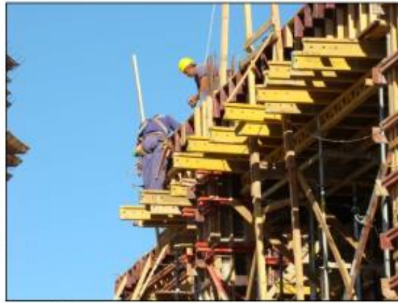
Montagem de estruturas
