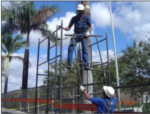
Montagem de andaimes
