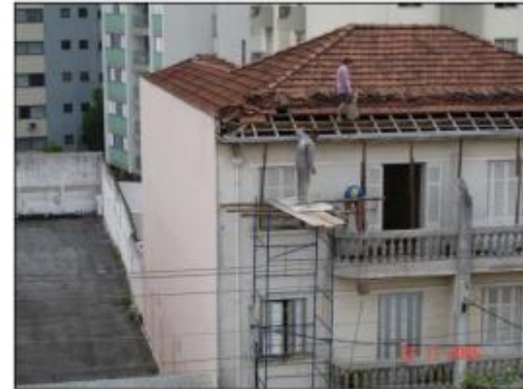
Telhados e Coberturas
