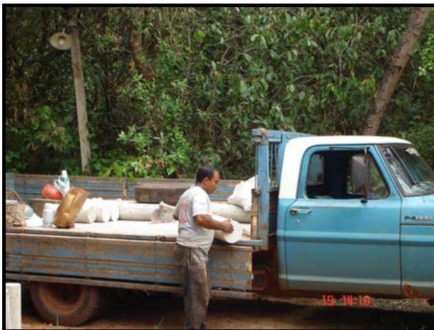
Figura 23 – Transporte dos segmentos de concreto.
