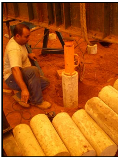
Figura 27 – Cravação dos segmentos de concreto.
