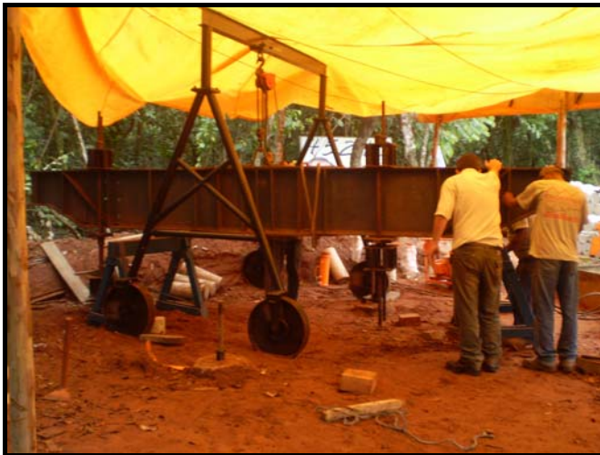
Figura 21 – Viga sendo Transladada.
