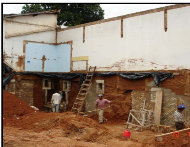
Figura 10 – Contenção provisória
