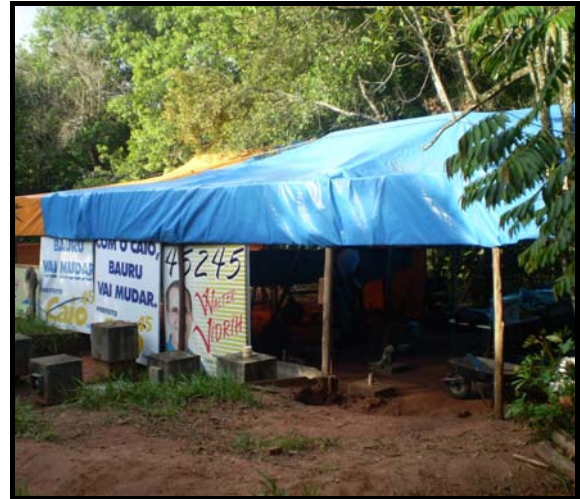
Figura 30 – Cobertura de lona concluída
