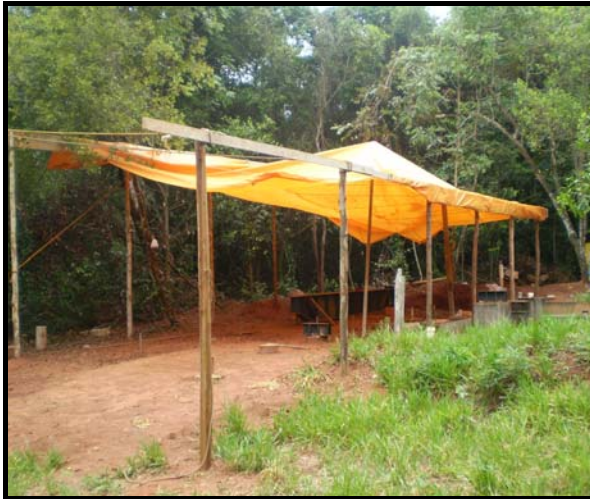
Figura 29 – Instalação da cobertura de lona.
