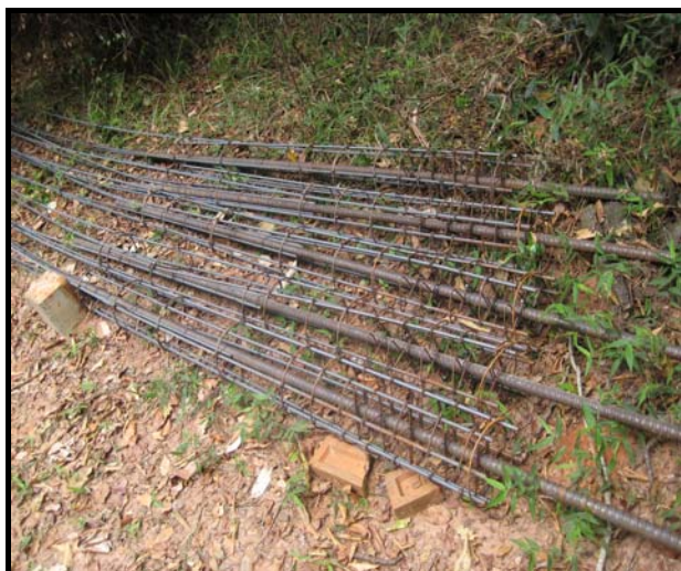
Figura 19 – Armaduras da estacas apiloadas.
