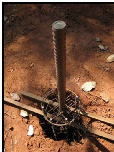
Figura 20 – Estaca pronta para ser concretada.
