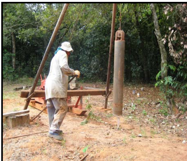
Figura 17 – Execução da estaca apiloada
