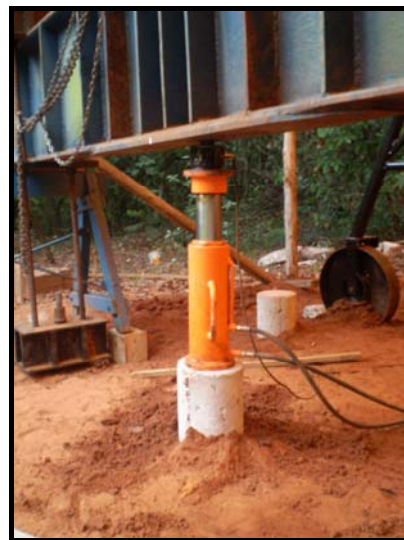
Figura 28 – Segmento de concreto sendo cravado.
