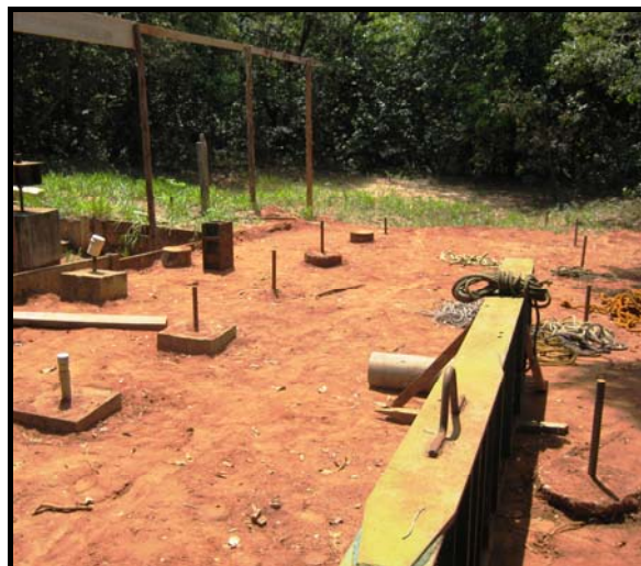
Figura 18 – Locação das estacas apiloada.
