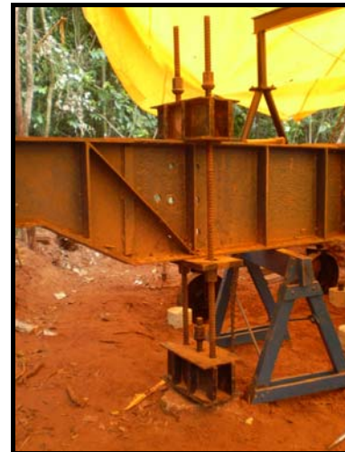
Figura 22 – Fixação da viga
