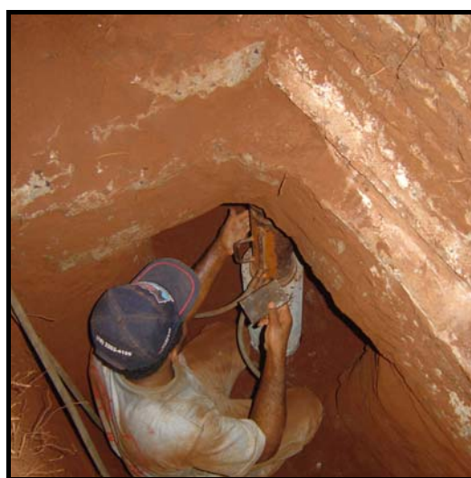
Figura 13 – Cravação da estaca
